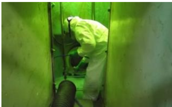
Figura 4c: Îndepărtarea peliculei de gel [2]
