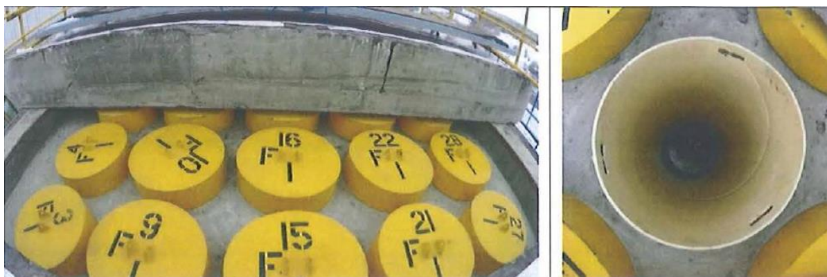
Fig. 10. Cilindrii din oțel carbon în care sunt stocate cartușele filtrante
