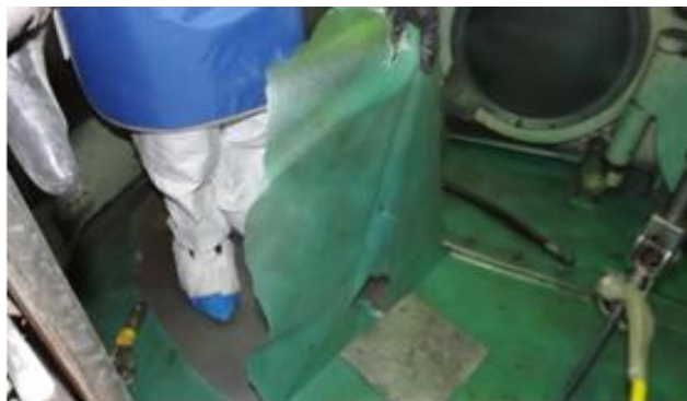
Figura 4b: Împrăștierea pe podea a decontaminantului [2]
