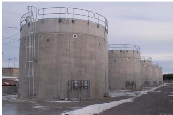
Figura 5 Module de depozitare a deșeurilor mediu radioactive Point Lepreau [5]
